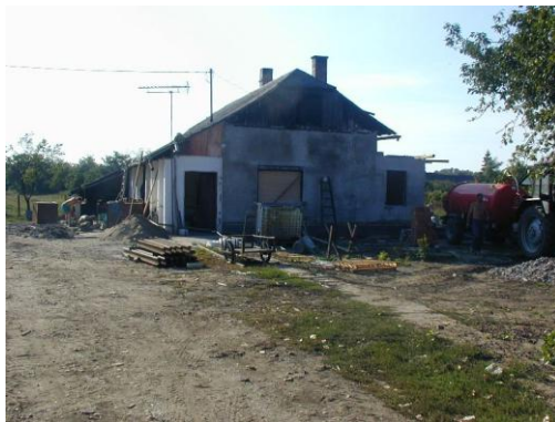
Felújítás alatt álló szeszfőzde (forrás: saját)
